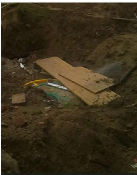
3. Cucine : n°1 Degrassatore prefabbricato in polietilene monoblocco TIPO ISEA FAMILY 250, di dimensioni in cm: l x L = 60x68, H = 82, [A.E.], di capacità pari a 250 litri, completo di coperchio a vite per ispezione/prelievo, prodotto con materiale interamente riciclabile. Volume utile 169 litri, conforme alla norma UNI EN 1825
